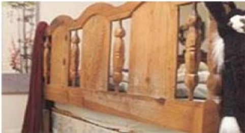
Formation de moisissures sur un panneau en bois dans une pièce très humide
